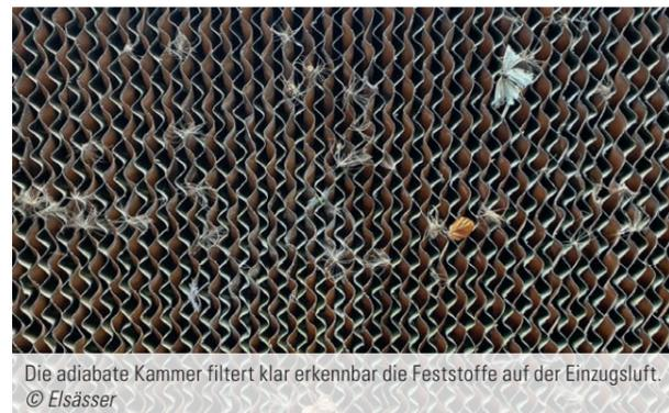
Die adiabate Kammer filtert klar erkennbar die Feststoffe auf der Einzugsluft. © Elsässer
